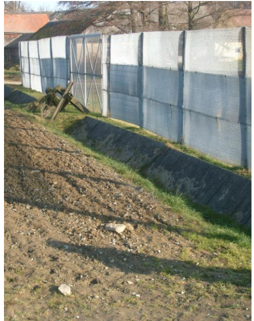
Blick auf den Kfz-Sperrgraben.
